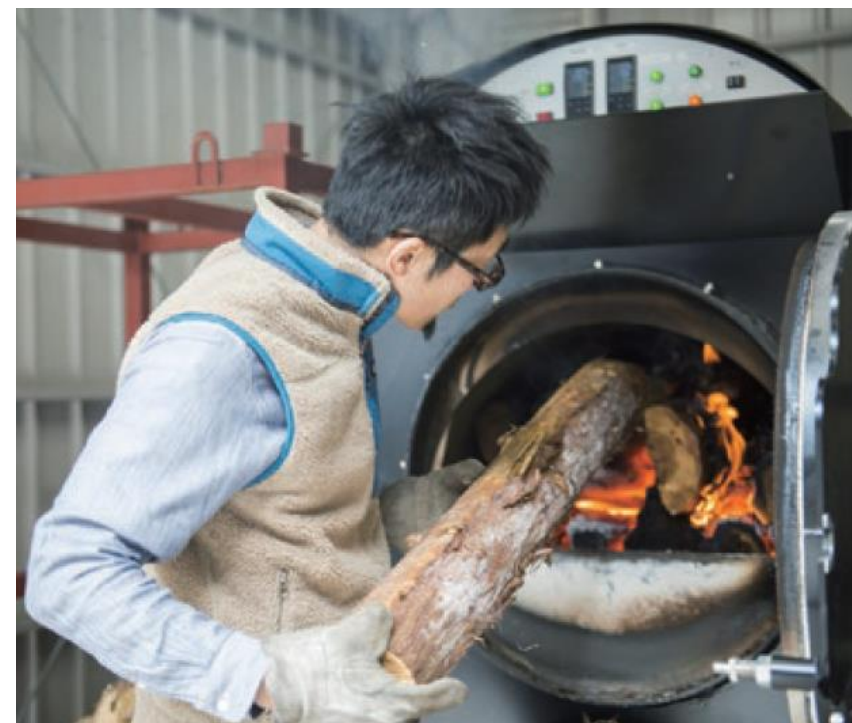
温泉施設の薪ボイラー
