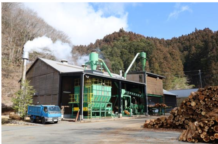
町の森林資源から木質バイオマス燃料を製造するペレット工場
