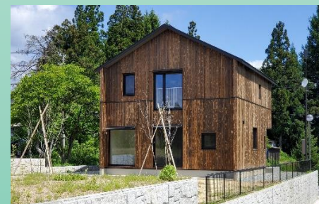
山形県の高断熱省エネ住宅
