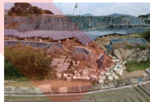
法面保護工が崩れて流出した事例
