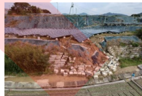
法面保護工が崩れて流出した事例
