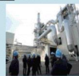
バイオマス発電所
