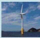
洋上風力発電施設
