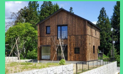
山形県の高断熱省エネ住宅
