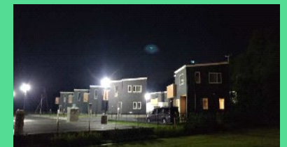
台風被害で停電したが、 迅速に復旧した千葉県睦沢市
